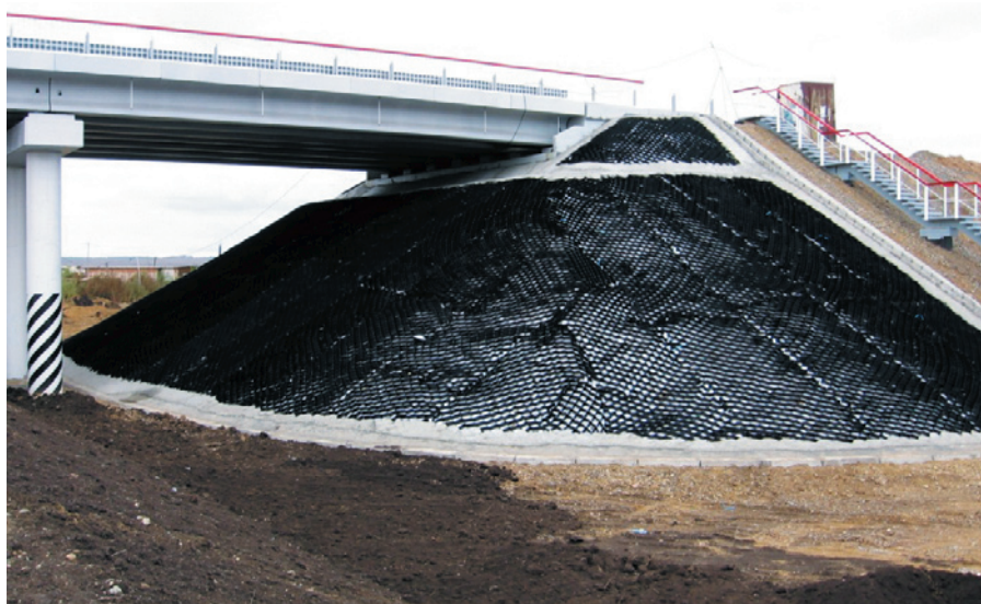
Рис. 3. Армирование поверхности откоса виадукта объемной георешеткой «ТехПолимер» (п. Емельяново Красноярского края)
