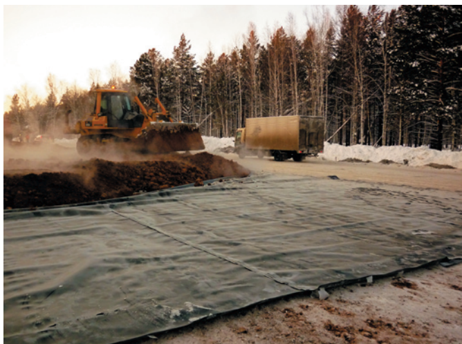
Рис. 1. Укладка геомембраны «ТехПолимер» в основание автодороги (участок федеральной трассы М-53 «Байкал»)
