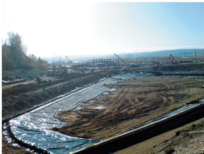
Рис. 2. Укладка геомембраны «ТехПолимер» на очистных сооружениях мостового перехода через р. Ангара (г. Иркутск)
