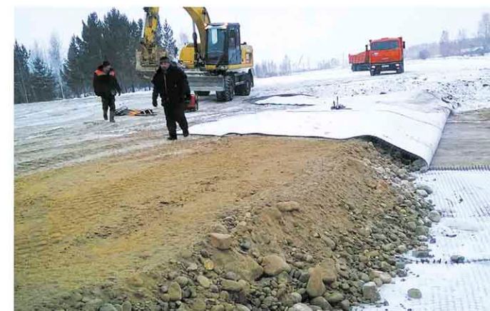
Армирование основания земляного полотна
