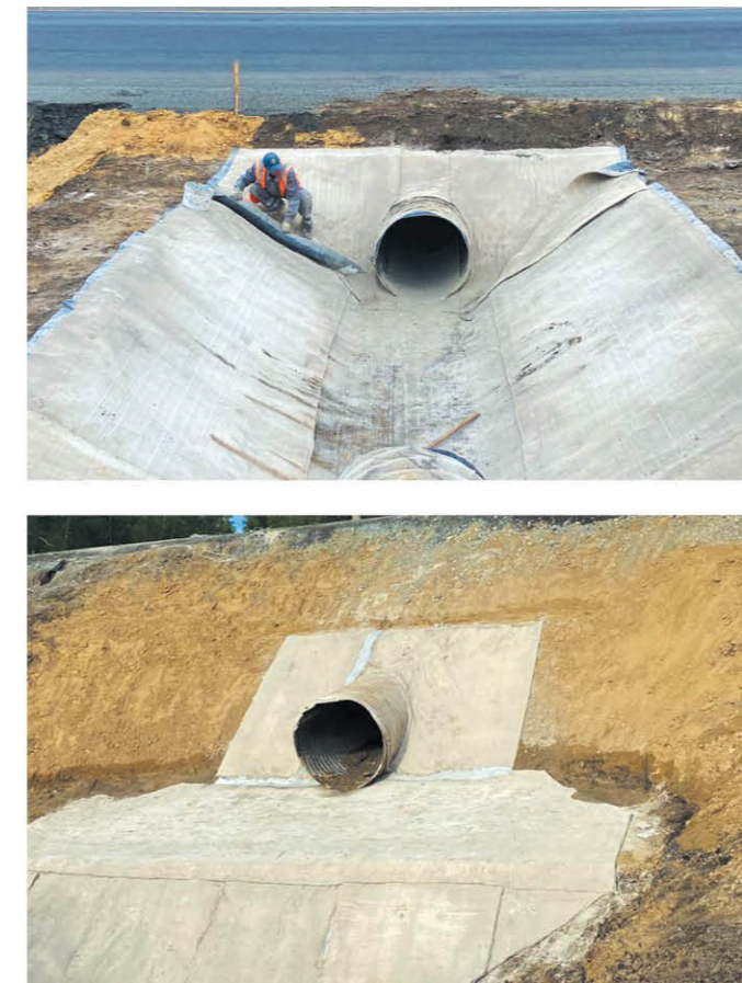
Тип 3. Водоотвод с применением бетонного полотна
