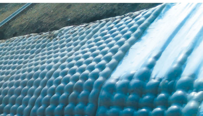
Берегоукрепление. Высокий уровень поверхностных вод
