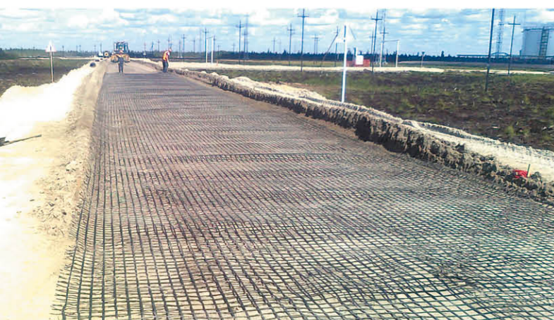
Армирование асфальтобетонных слоёв
