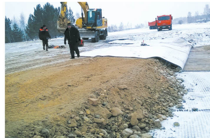
Армирование основания земляного полотна
