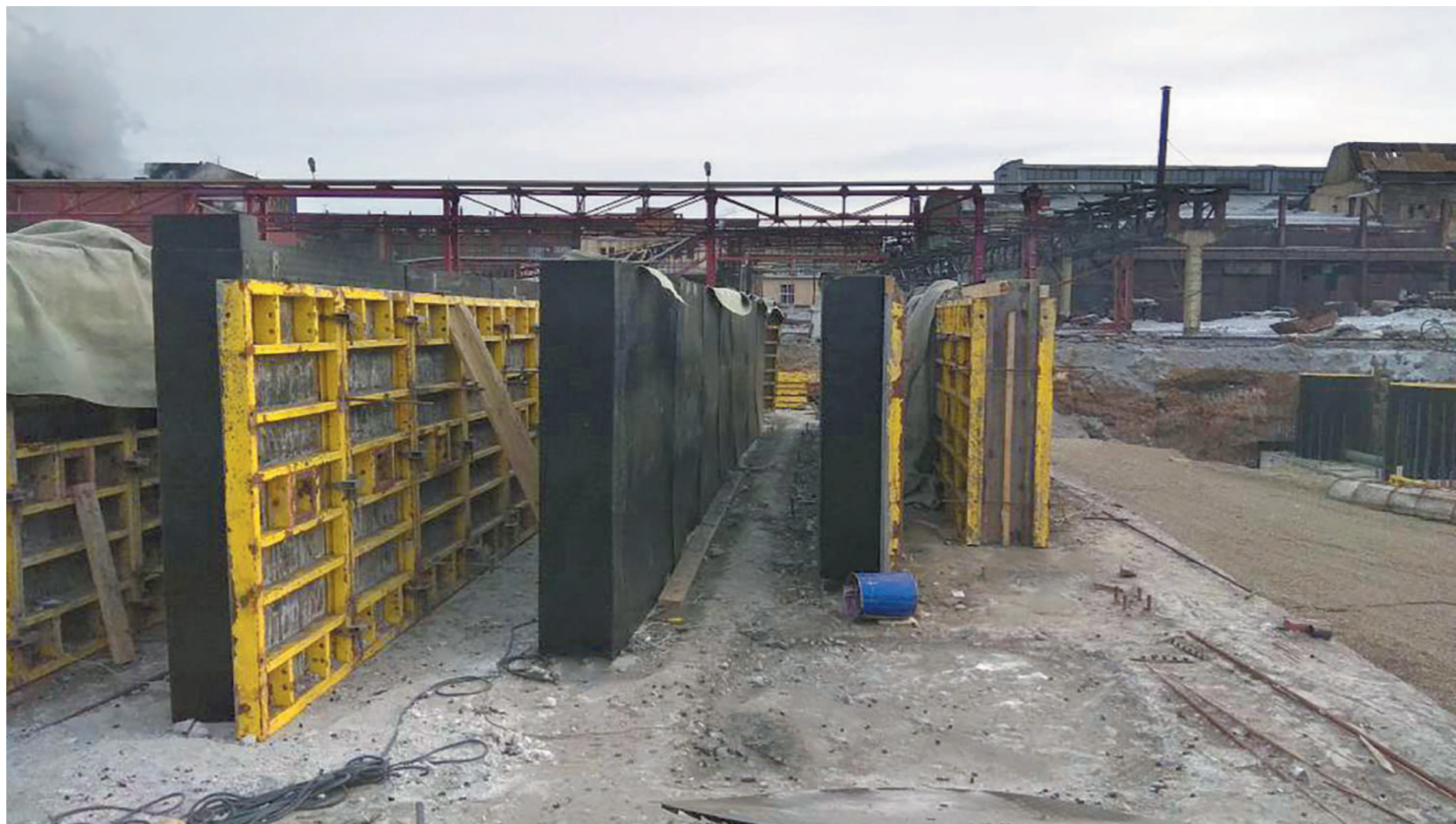
4. Демонтаж щитовой опалубки
