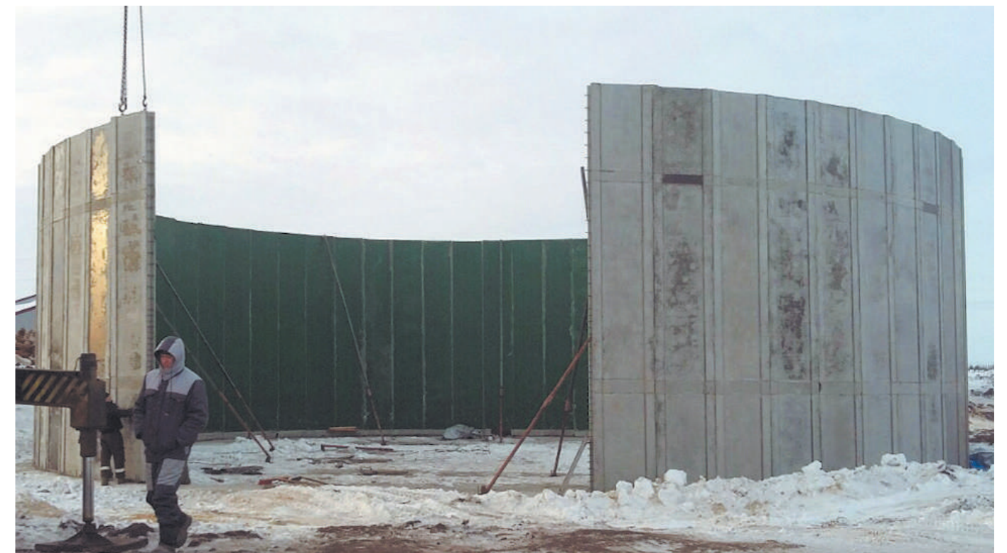
4. Монтаж стеновых панелей
