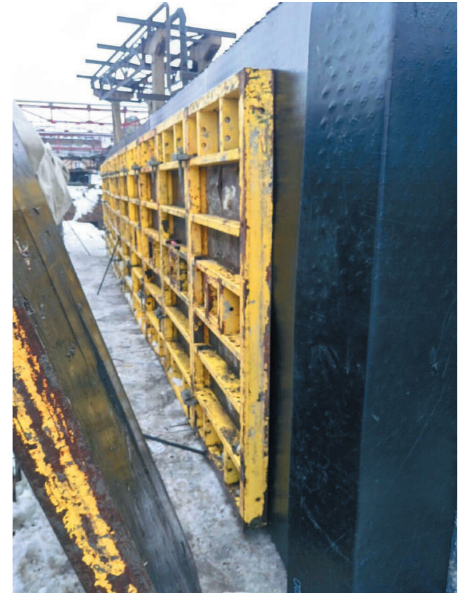
3. Монтаж щитовой опалубки
