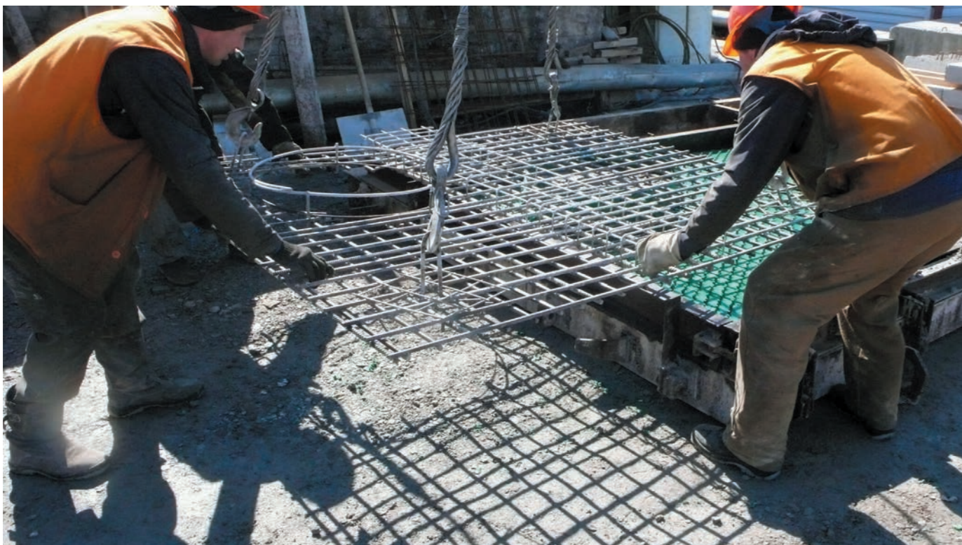
3. Установка арматурного каркаса
