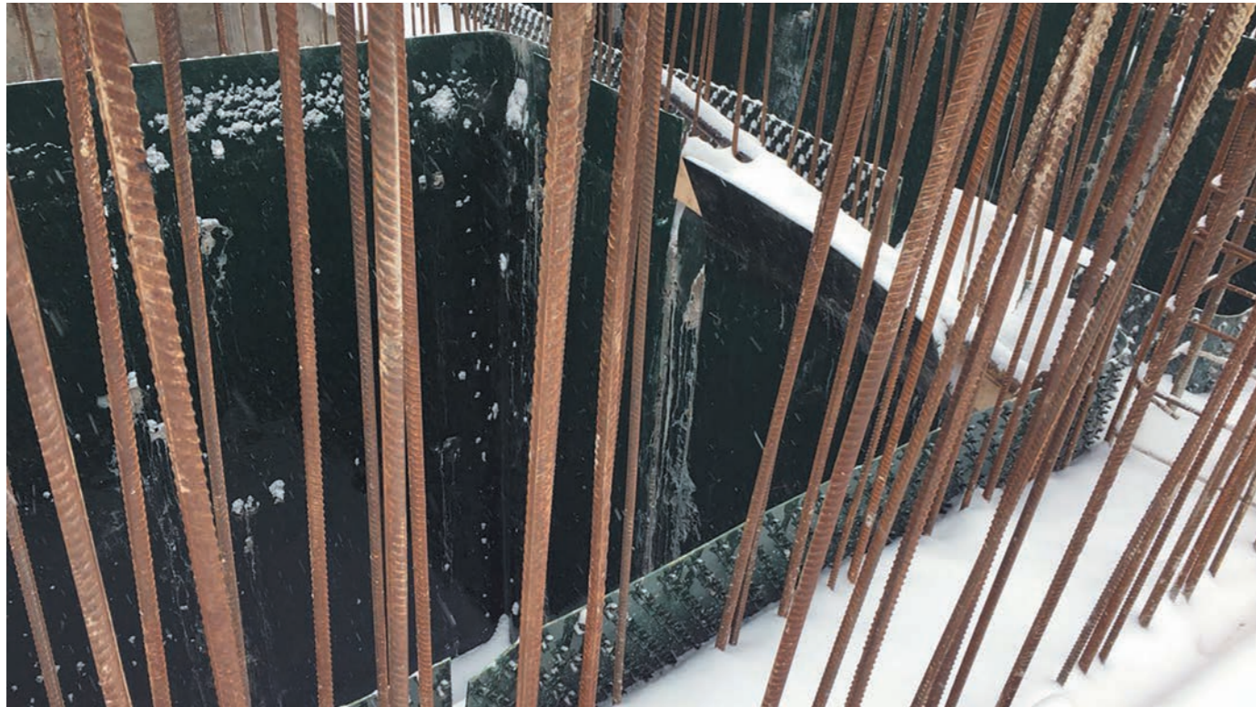
1. Установка анкерного листа в проектное положение (внутренние углы с гибкой листа)
