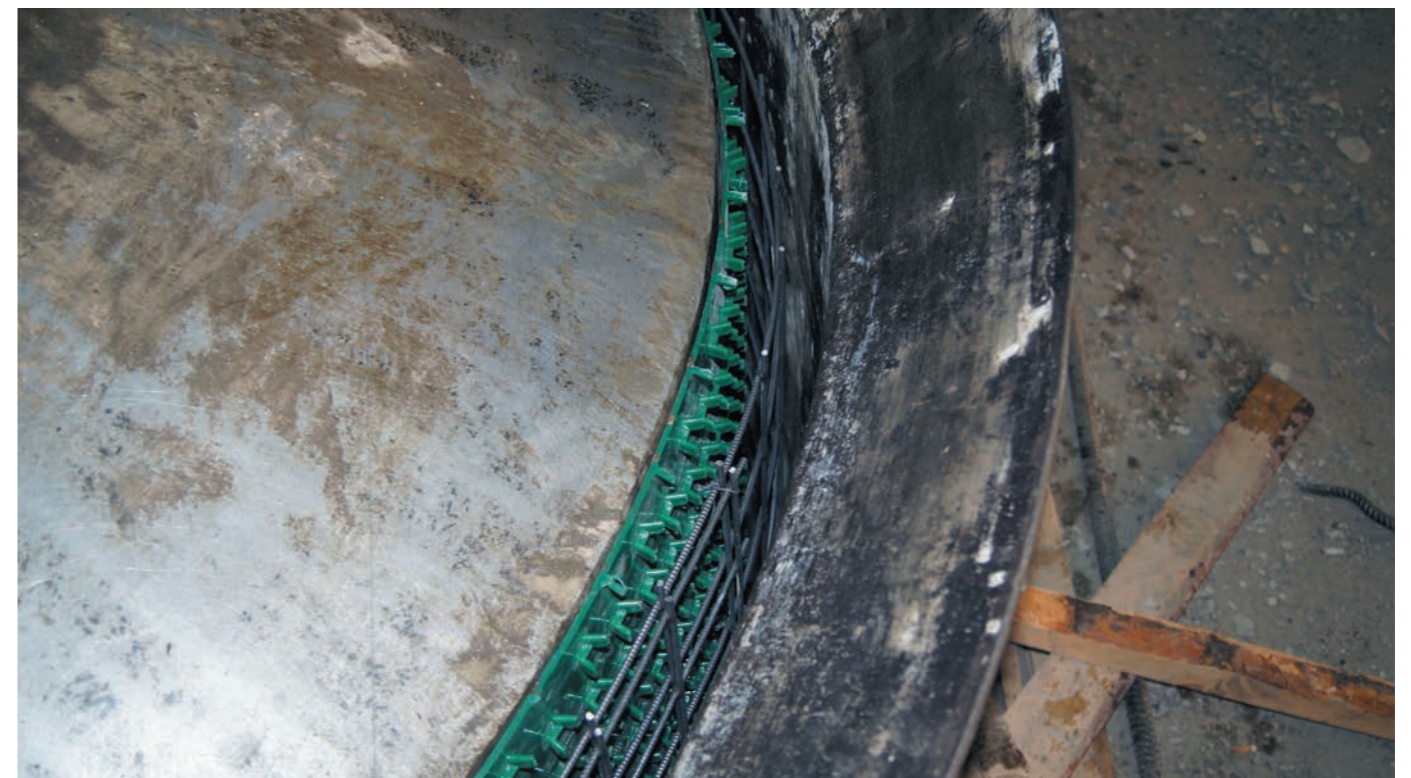
3. Арматурный каркас и анкерный лист в опалубке
