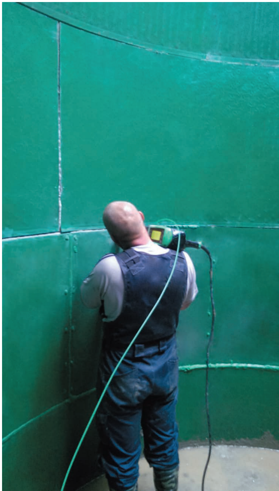
4. Экструзионная сварка встык
