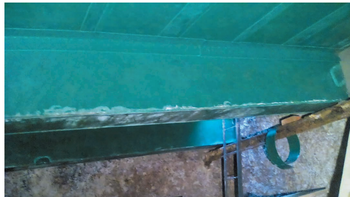
7. Герметизация швов монтажной полосой
