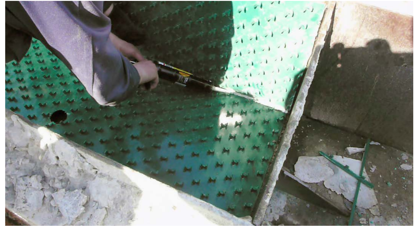
2. Герметизация швов
