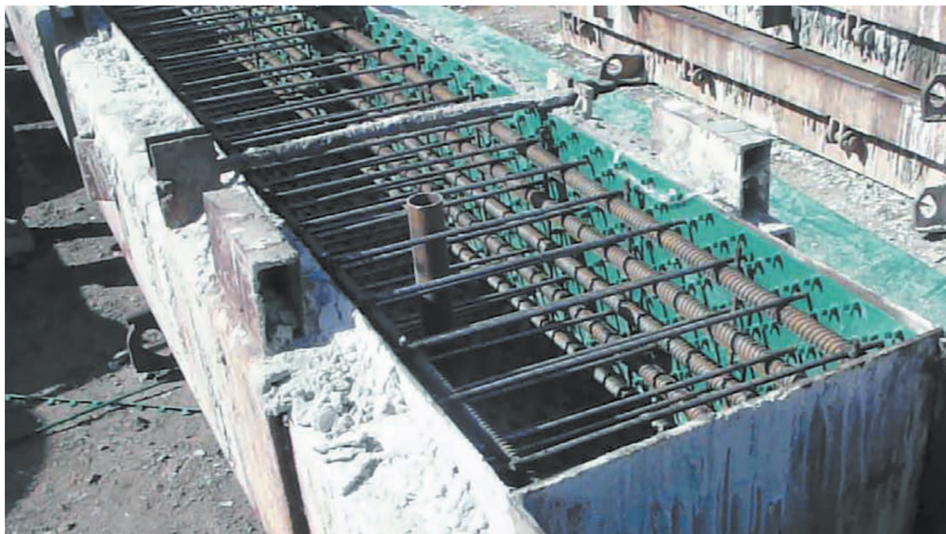
3. Монтаж арматурного каркаса
