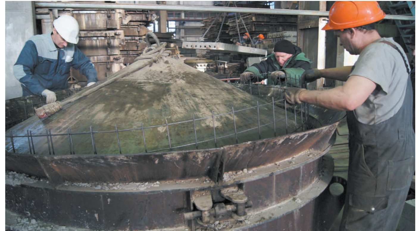
2. Установка арматурного каркаса
