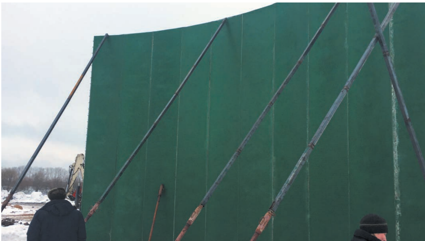
3. Монтаж стеновых панелей
