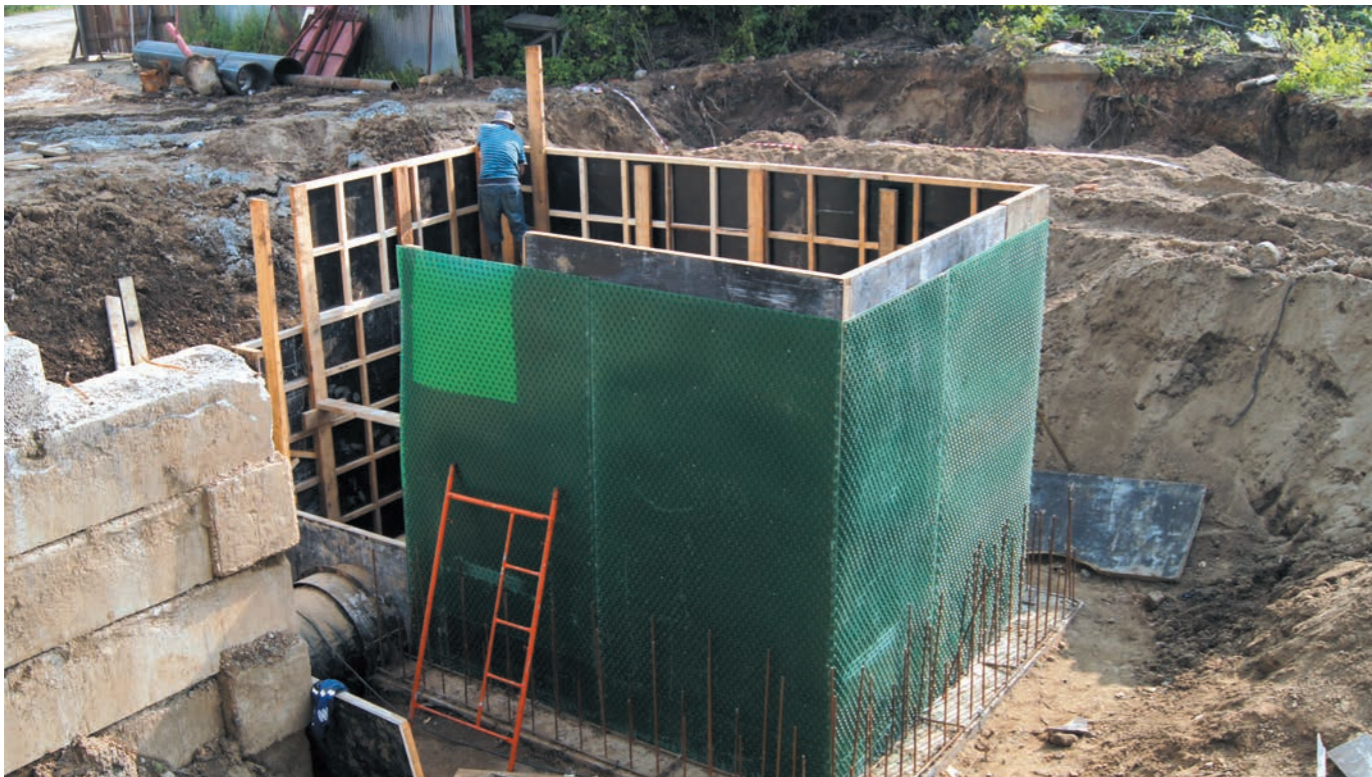
3. Монтаж анкерного листа на опалубку встык
