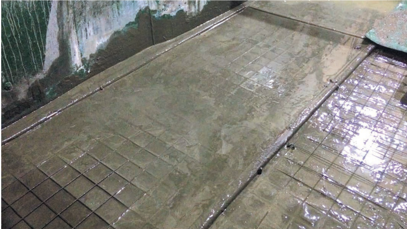
1. Монтаж анкерных листов
