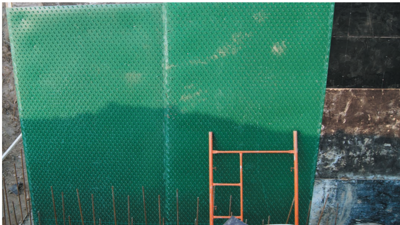
5. Экструзионная сварка листов встык
