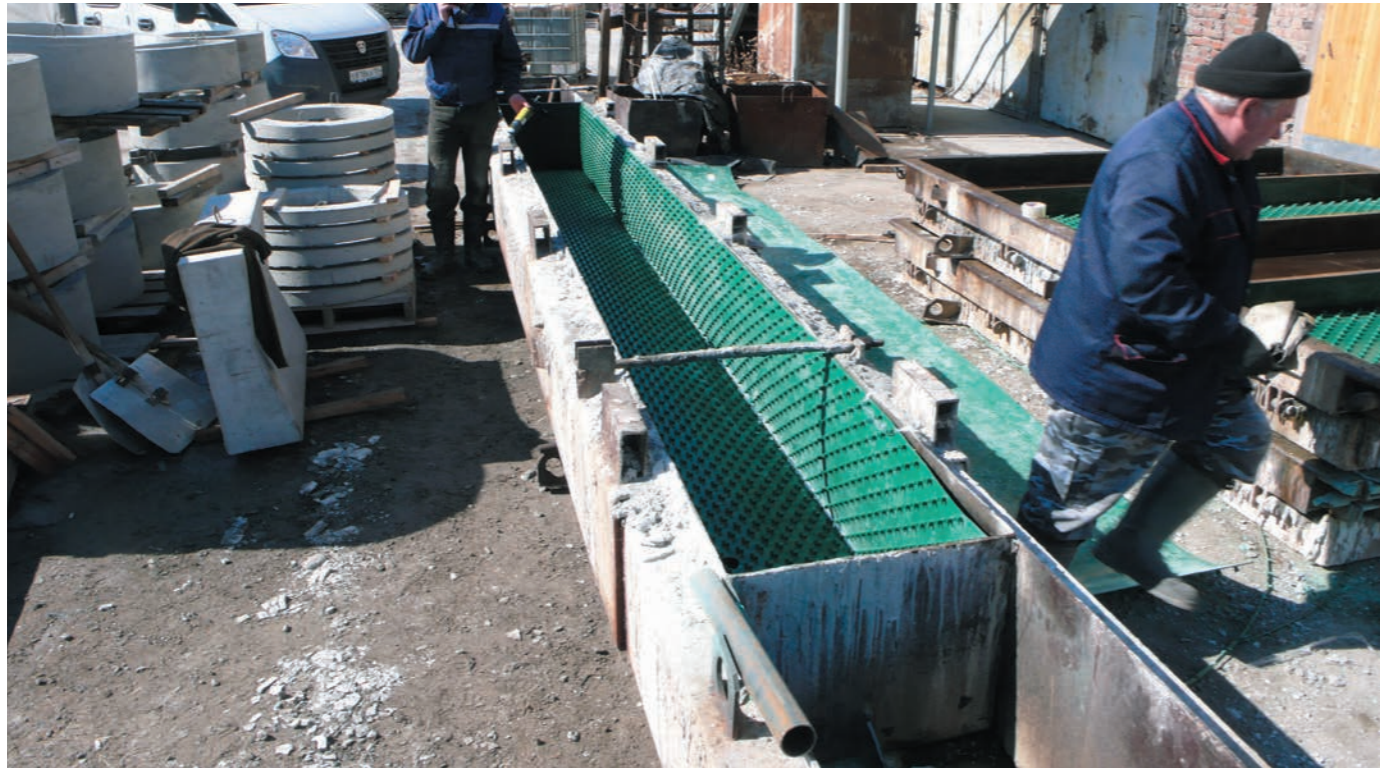
1. Установка анкерного листа в опалубку
