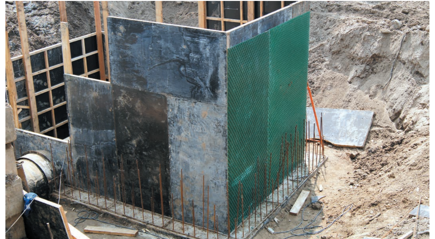
2. Монтаж анкерных листов на опалубку встык
