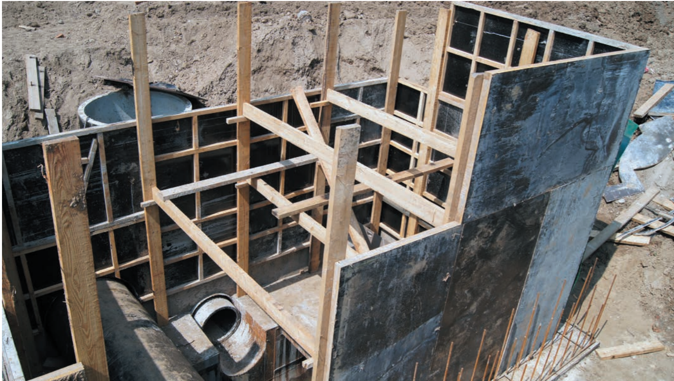
1. Монтаж опалубки
