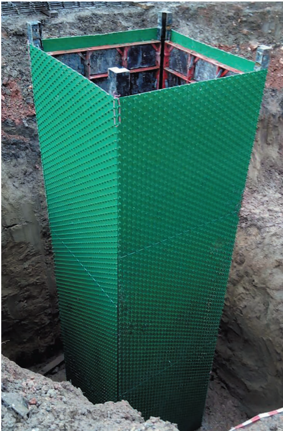
1. Монтаж анкерного листа на опалубку
