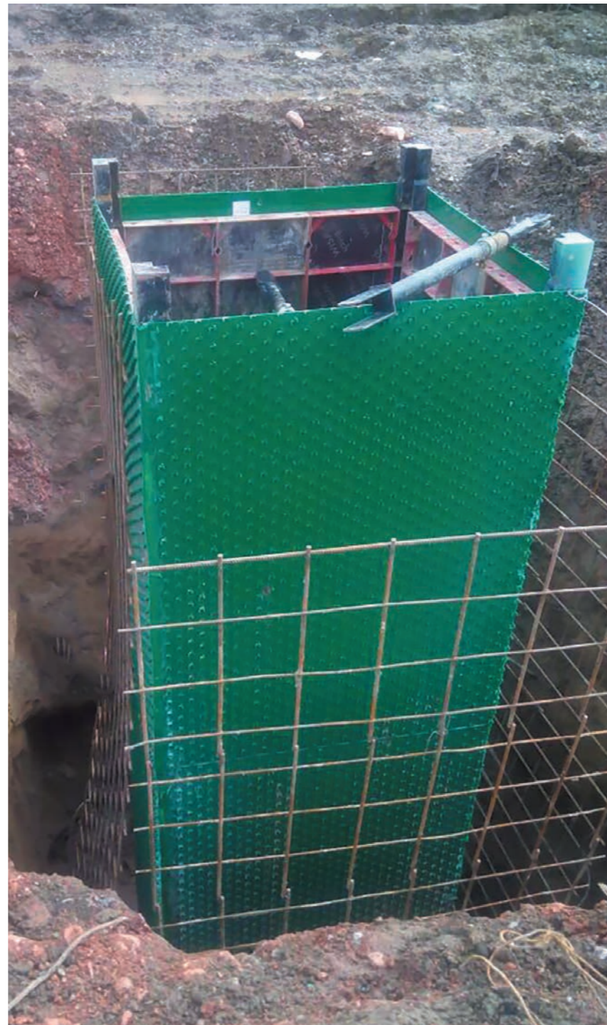
2. Установка арматурного каркаса
