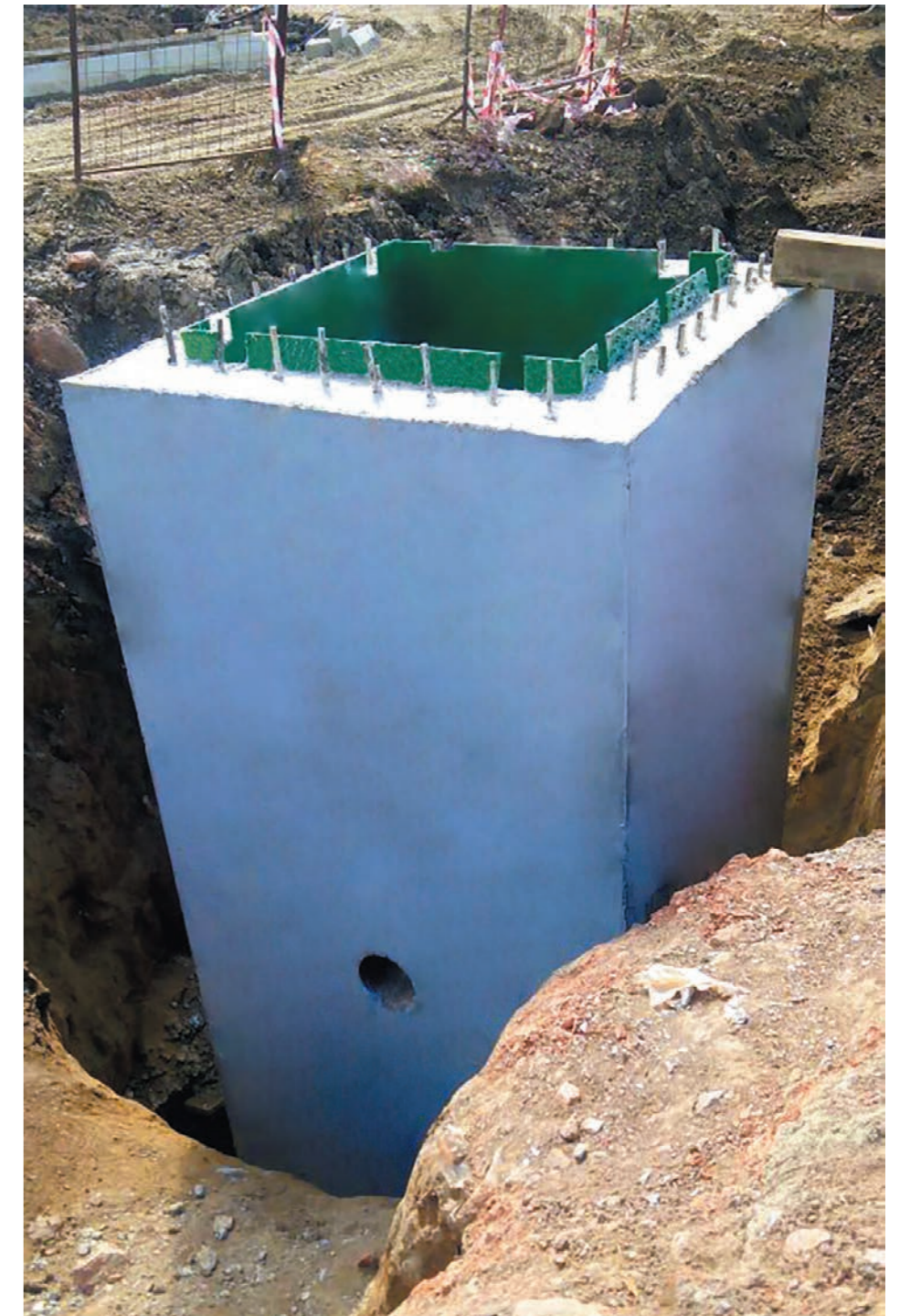
3. Монолитная конструкция после демонтажа опалубки
