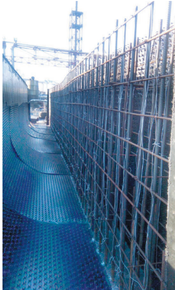
1. Установленный арматурный каркас, подготовка анкерных листов к монтажу
