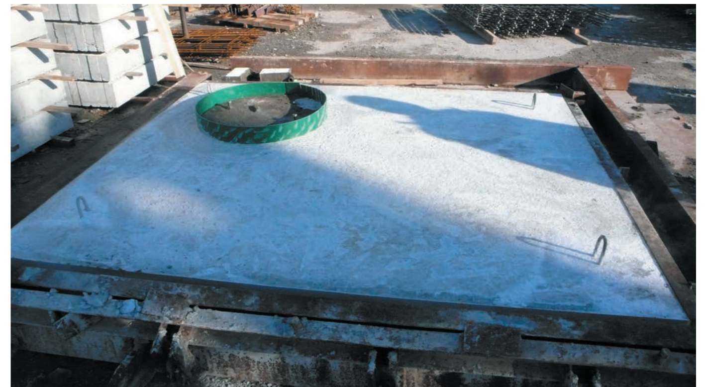
4. Заливка бетона
