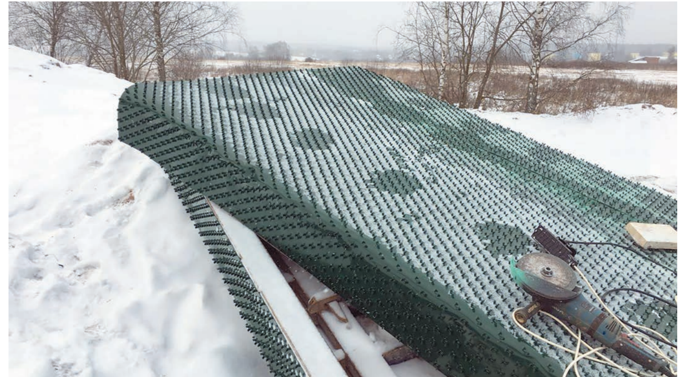
2. Монтаж анкерного листа на опалубку перед установкой
