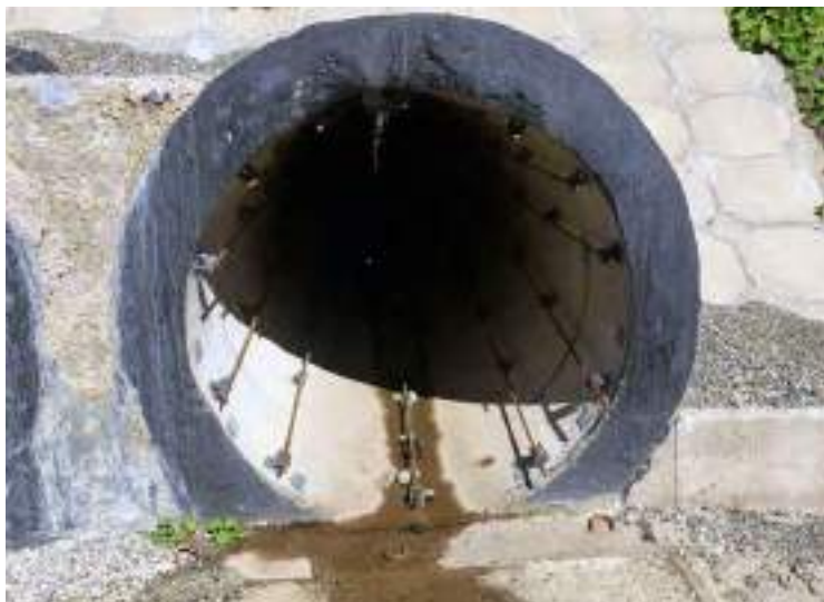
Продольный арматурный каркас
