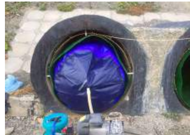
Подготовка к заливке смеси (монтаж опалубки)
