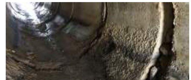
Коррозия бетона
