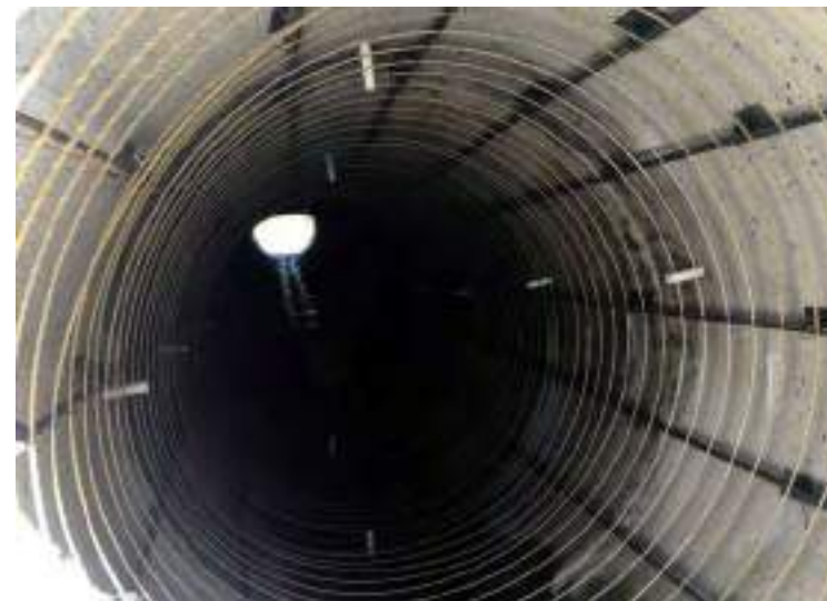
Установленный арматурный каркас
