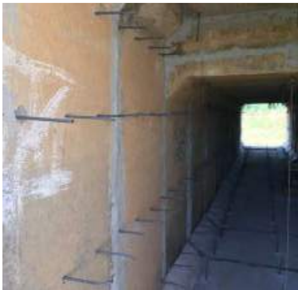
Установка анкеров из арматуры
