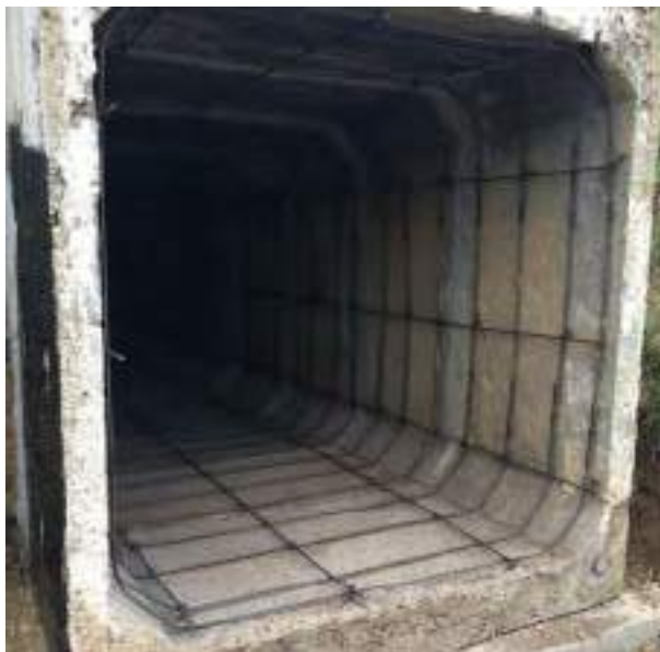
Установка арматурного каркаса
