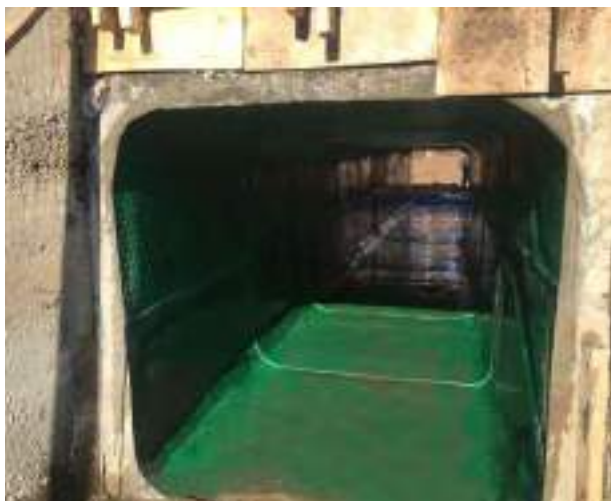
Труба после ремонта
