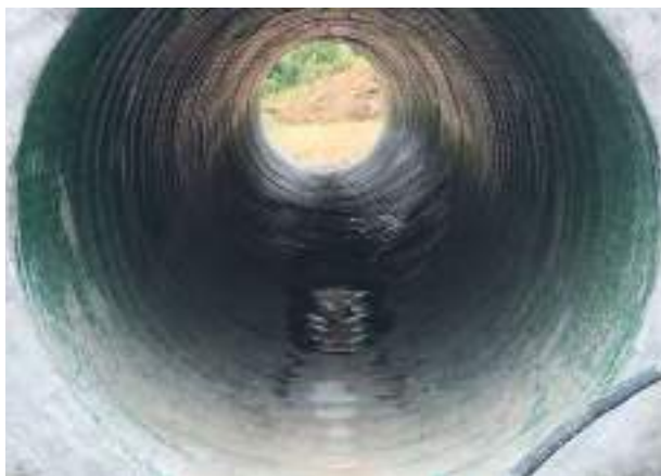
Равномерная ребристая поверхность трубы
