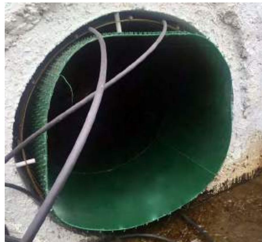
Подготовка к заливке смеси
