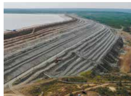
Рис. 4. Хвостохранилище обогатительной фабрики № 3
